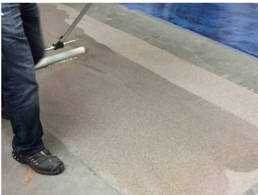
Foto: Aanbrengen primer.
