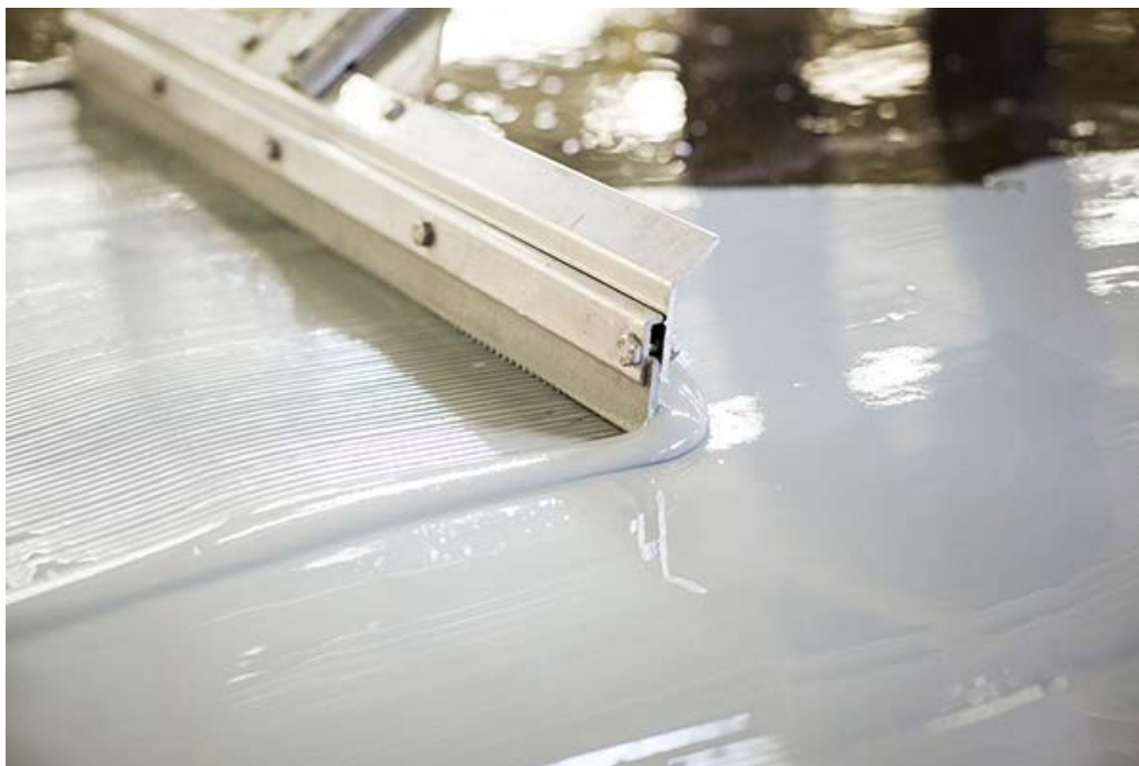
Foto: Aanbrengen vloeistofdicht beschermstelsel.
